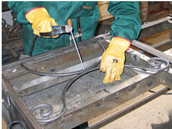
17.- Colocamos un punto de soldadura a una cara, puede ocurrir que con el punto de soldadura se doblen ligeramente.
