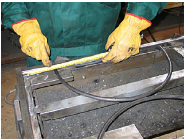
15.- El arco inferior debe quedar totalmente centrado por ambos lados.
