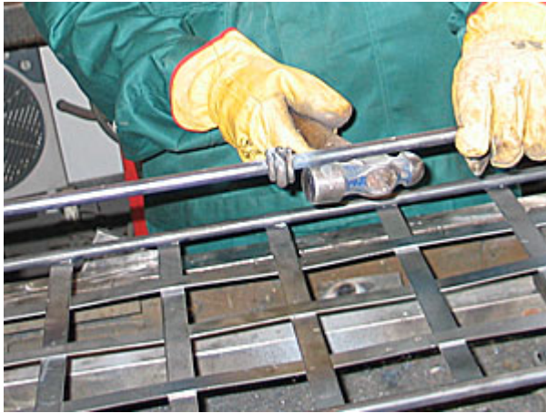
35.- Después de un ligero punto de soldadura utilizo el martillo para igualar la vertical.
